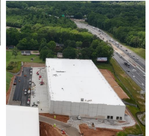
Bild: CarBatteryReFactory 2, Greenville
